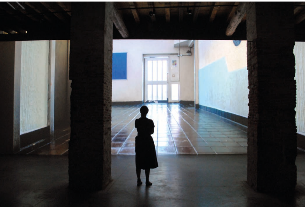
Fig.5 - Robin Hood Garden. Sito in demolizione (dicembre 2017). ©Elio Di Pace
