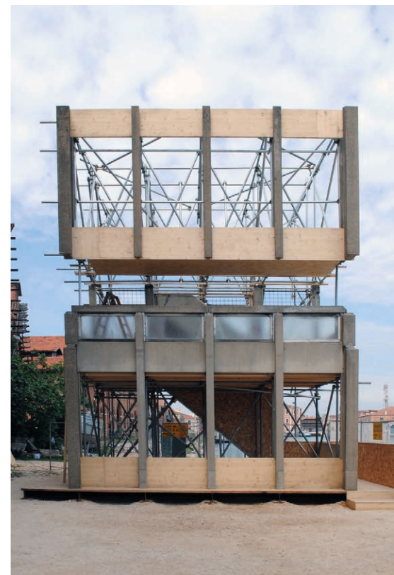
Fig.2 - Il frammento della faccia dei Robin Hood Gardens, conservata dal Victoria and Albert Museum. ©designboom (> link )
