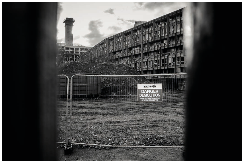
Fig.1 - Robin Hood Garden. Sito in demolizione (dicembre 2017). ©Elio Di Pace
