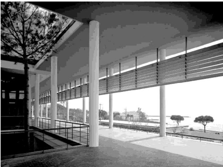
5.2.2. Entrance portico (G. Cosenza (edited by), Luigi Cosenza. La Fabbrica Olivetti a Pozzuoli , Naples 2006)
