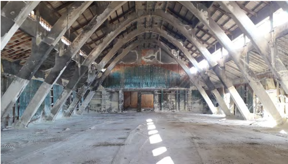
Fig.07 – Foto dell'interno del manufatto alla data di dismissione di deposito del sale (Antonio Riondino 2020)
