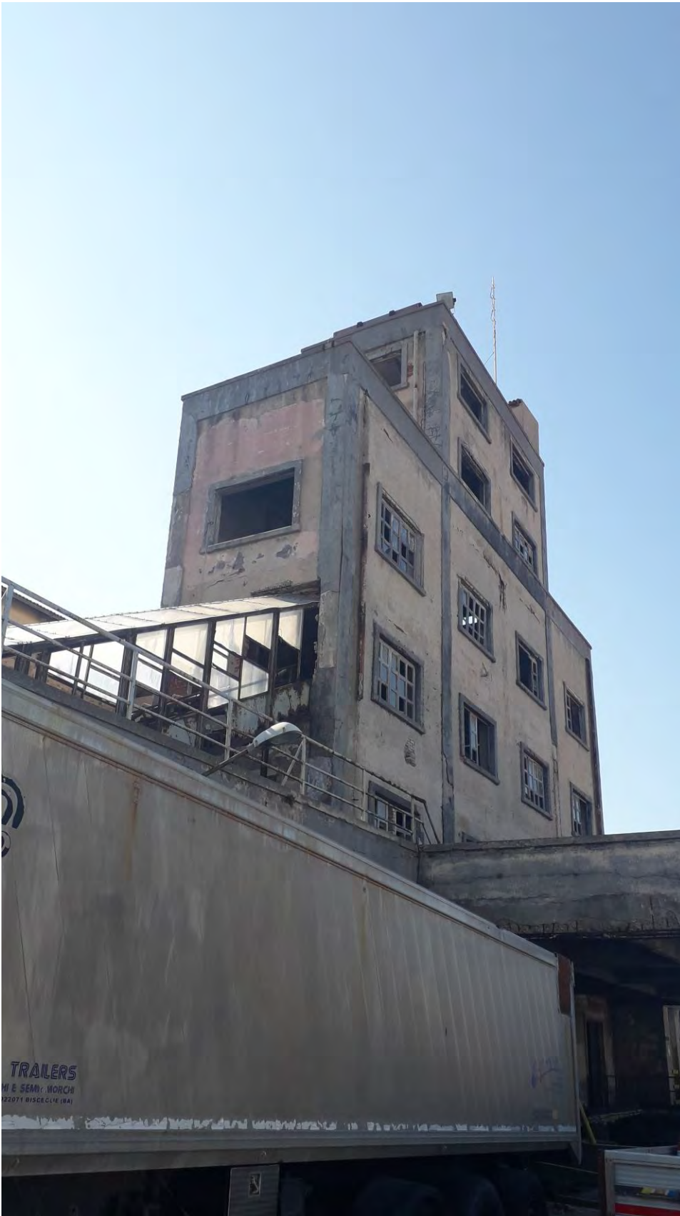
Fig.10 – Foto della torre tecnica (Antonio Riondino 2020)
