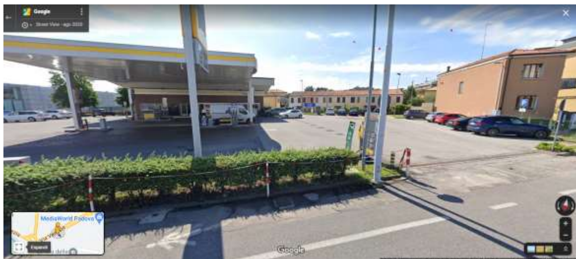
Stazione Agip di Padova in Via Venezia. Fotocopia di quella di Belluno
