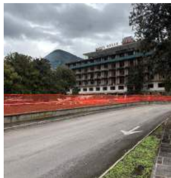
Fig.9 - Cantiere per la demolizione dell'Hotel delle Terme, 2026 [Castellammare di Stabia, Fotografia di Francesca Di Fusco]
