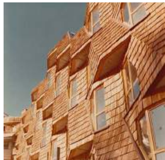
Fig.3 - Fotografia storica della facciata dell'albergo-villaggio, 1978 (Fondazione MAIRE)
