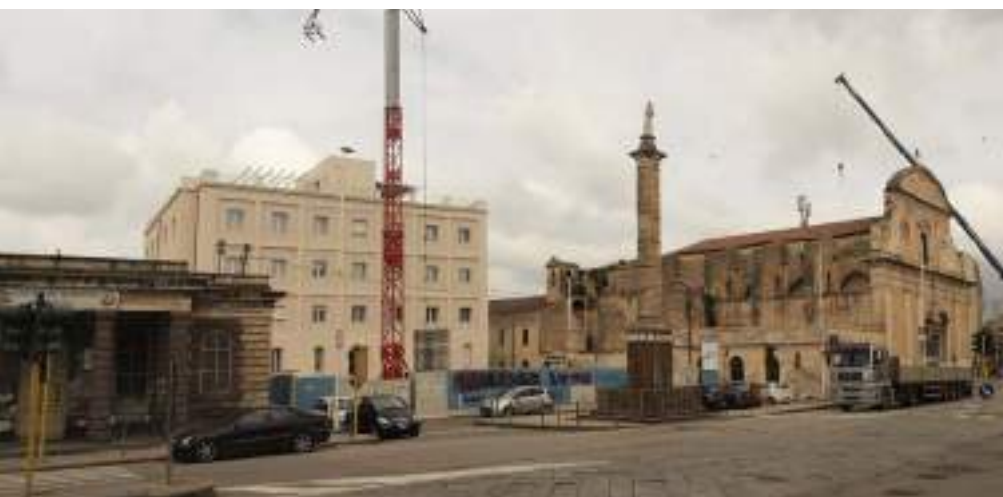
Fig.5 - Fotografia dell'edificio in fase di restauro. Si noti a sinistra il casotto daziario e a destra la Chiesa di Sant'Antonio (fotografia dell'autore, 2026)
