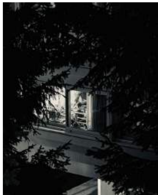
Fig.6 - Dettaglio dei bow-windows in facciata. (foto dell'autore, 2026)
