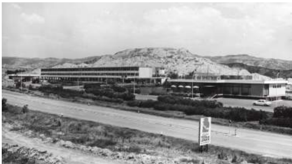
Fig.2 - Il sistema della stazione di servizio Agip di Pisticci visto dalla strada statale Basentana. Ristorante, stazione di rifornimento e motel (Fotografia Ramosini-Bari, 1969-1973, immagini esterne edificio, 18x24 cm, busta 4001, fascicolo 149, Archivio storico Eni © Eni)
