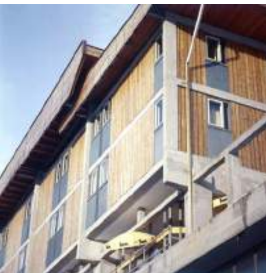
Fig.8 - Dettaglio dei materiali del Motel Agip di Cortina d'Ampezzo: cemento armato, legno e pittura azzurra. Fonte: Archivio Progetti luav, Università luav di Venezia
